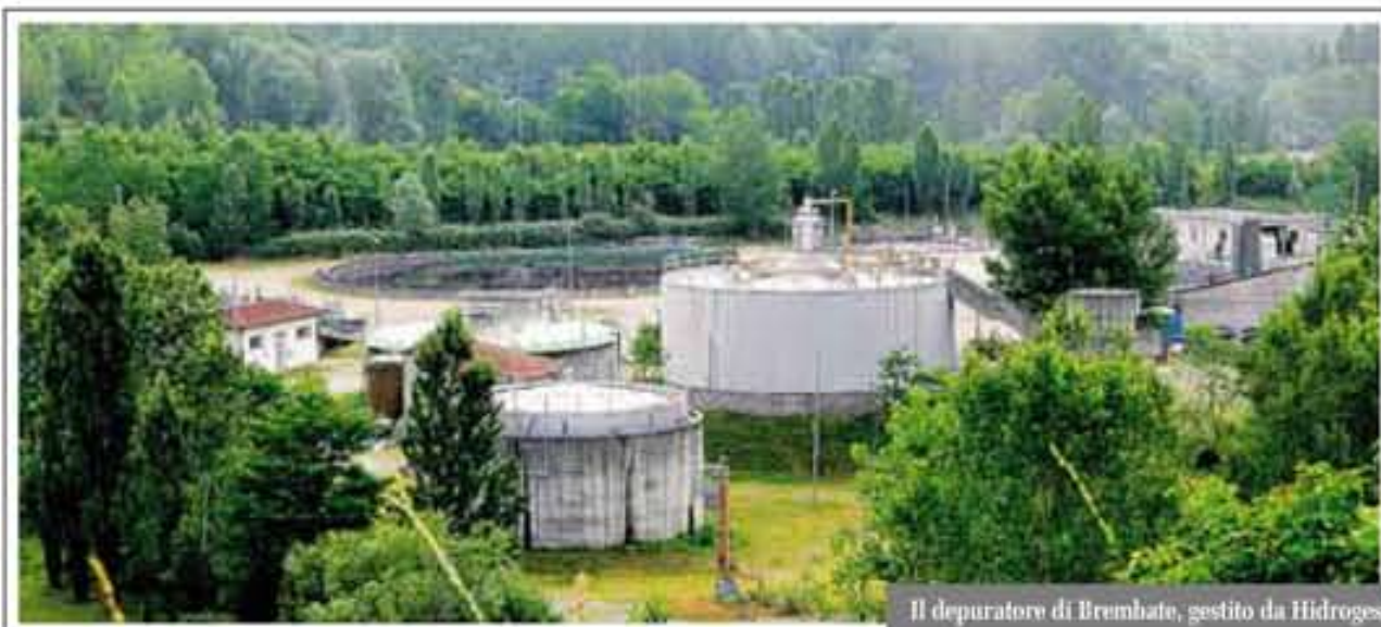
Il depuratore di Brembate, gestito da Hidrogest
