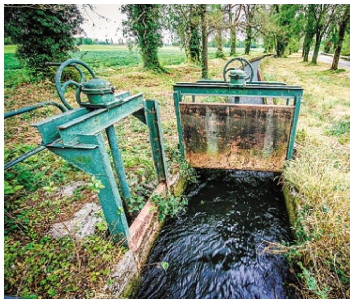
I livelli delle rogge e dei canali sono sotto osservazione
