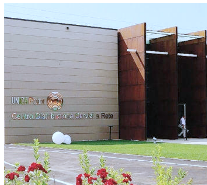
La sede di Unica Point a Sotto il Monte Giovanni XXIII
